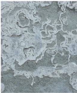
Degradazione differenziale
