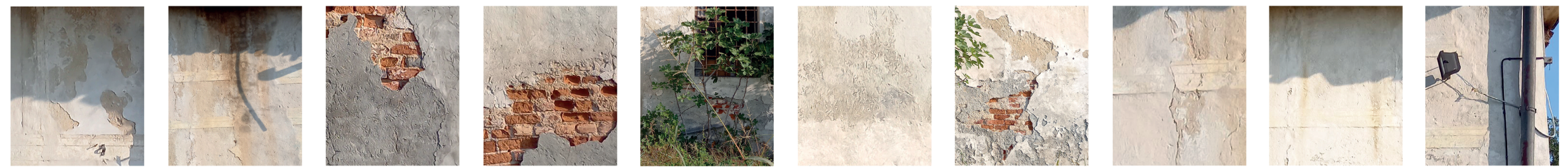
Distacco Macchia Risarcitura incompatibile Erosione Presenza di vegetazione Degradazione differenziale Lacuna e distacco Fessurazione non passante Colatura Apposizione incompatibile
