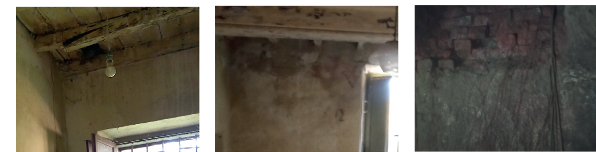
Solaio con fessurazione, piano terra Infiltrazioni dal tetto, piano primo Presenza di vegetazione nella cantina
